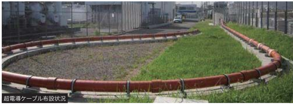
超電導ケーブル布設状況
