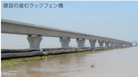
建設の進むラックフェン橋
