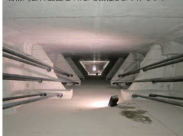
橋桁内部に配置されたPE被覆ECFストランド
