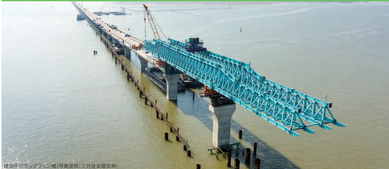
建設中のラックフェン橋(写真提供:三井住友建設(株))
