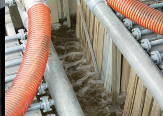
排水を浄化するポアフロン®モジュール。石油化学のプラントの排水処理では特に効力を発揮する
