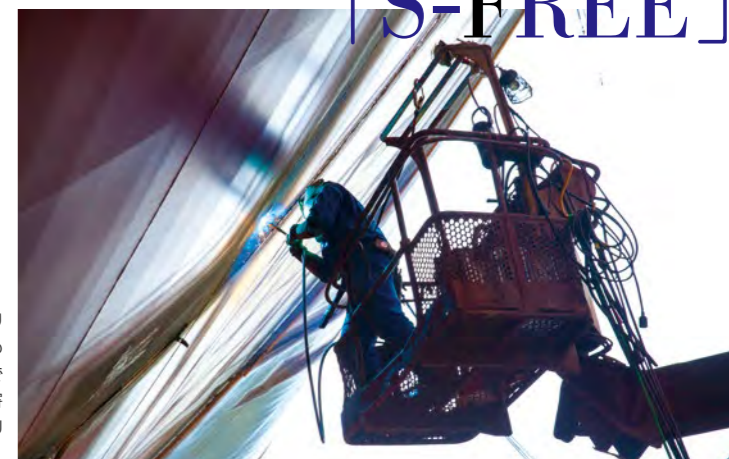
アーク溶接。より安全、快適が求められる高所作業でも、S-FREE®は寄与している(JMU呉事業所)
