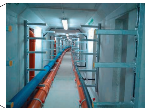
共同溝内に敷設されたMCFケーブル
