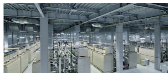
2F: セルスタック、熱交換器 Floor 2: Cell stack and heat exchanger
