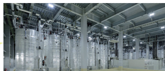
1F: タンク、ポンプ、交直変換装置 Floor 1: Tank, Pump and PCS
