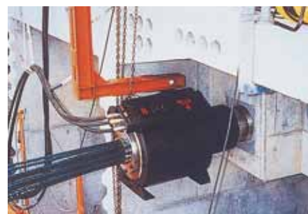
■ 緊張ジャッキ
