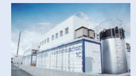
米国に導入したレドックスフロー電池
