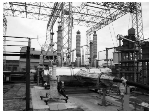
写真4 終端接続部（端末）
