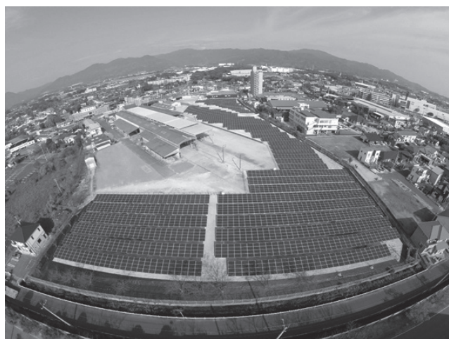
写真2 1MW太陽光発電所の全景写真
